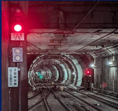
現在のトンネル
