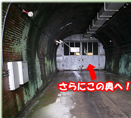
トンネルの入口から奥を望む
