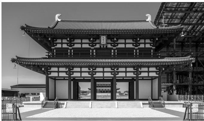
図3 復元された大極門（中央）と復元工事中の東楼（右端） 写真提供 奈良文化財研究所
